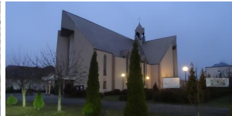
Trzecia wieża czyli sygnaturka na kościele św. Faustyny
