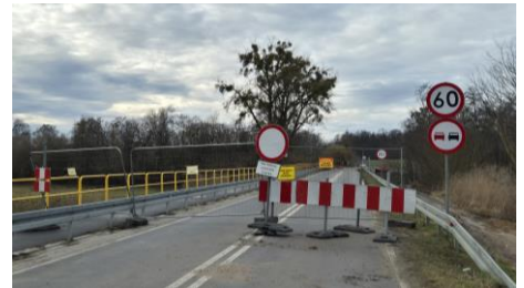
Most nad kanałem Ślesieńskim jest od września 2024 r. przebudowywany. Fot. Wanda i Maria Gruszczyńskie
