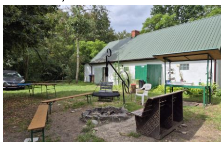
Miejsce sanitarne na szlaku rowerowym – ten projekt zapewnił fundusze na remont budynku ze świetlicą
