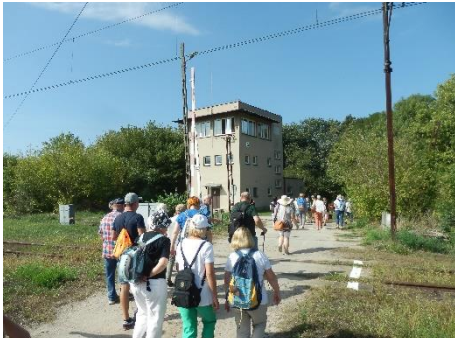
Stacja Cukrownia z nastawnią
