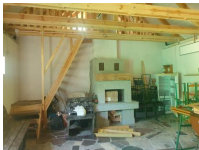
Prace przy kominku są kontynuowane
