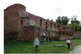
Grube mury zamku Dybów
