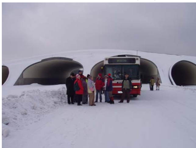
2006-02-26 Autostrada A2 w budowie
