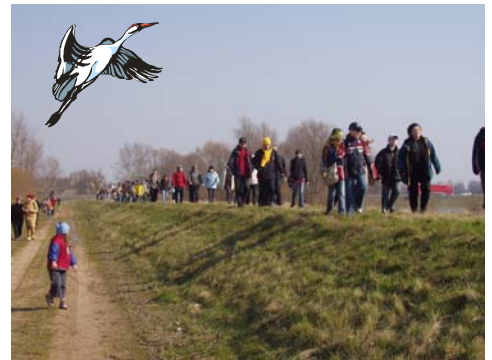
Pokonałmy idąc wałem 8 km trasę Sługocinek – Dolany, mijając wsie Sługocin i Ratyń. Początek trasy miał miejsce na 384 km, a zwrot wału na północ na 376,6 km biegu Warty
